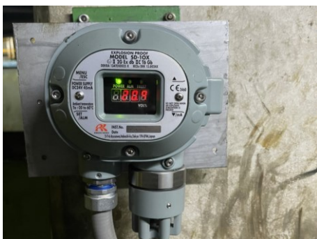
ภาพที่ 2.2-42 การติดตั้ง Gas Detector
