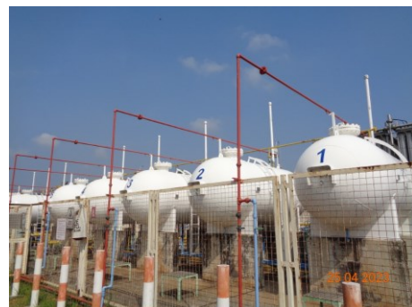
ภาพที่ 2.2-43 การติดตั้ง Sprinkler บริเวณลานถังเก็บ LPG
