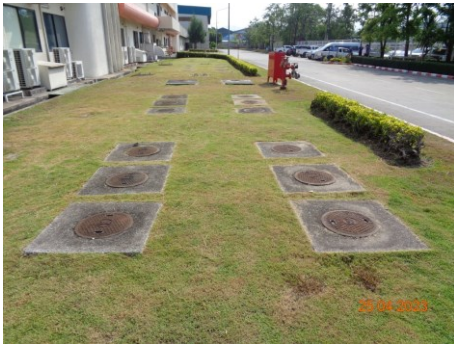
ภาพที่ 2.2-7 ระบบบำบัดน้ำเสียสำเร็จรูป แบบถังเกรอะ (Septic Tank)
