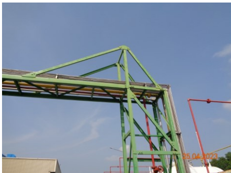
ภาพที่ 2.2-40 การยกระดับแนวท่อ LPG ให้สูงจากระดับพื้น
